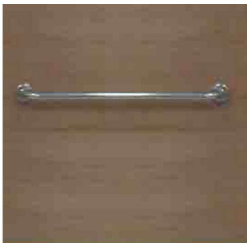
รูปที่ 15 ราวจับที่ใช้ในพื้นที่ทั่วไป ใช้วัสดุเป็นสแตนเลส (ผศ. ไตรรัตน์ จารุทัศน์ และคณะ) พ.ศ.2548
